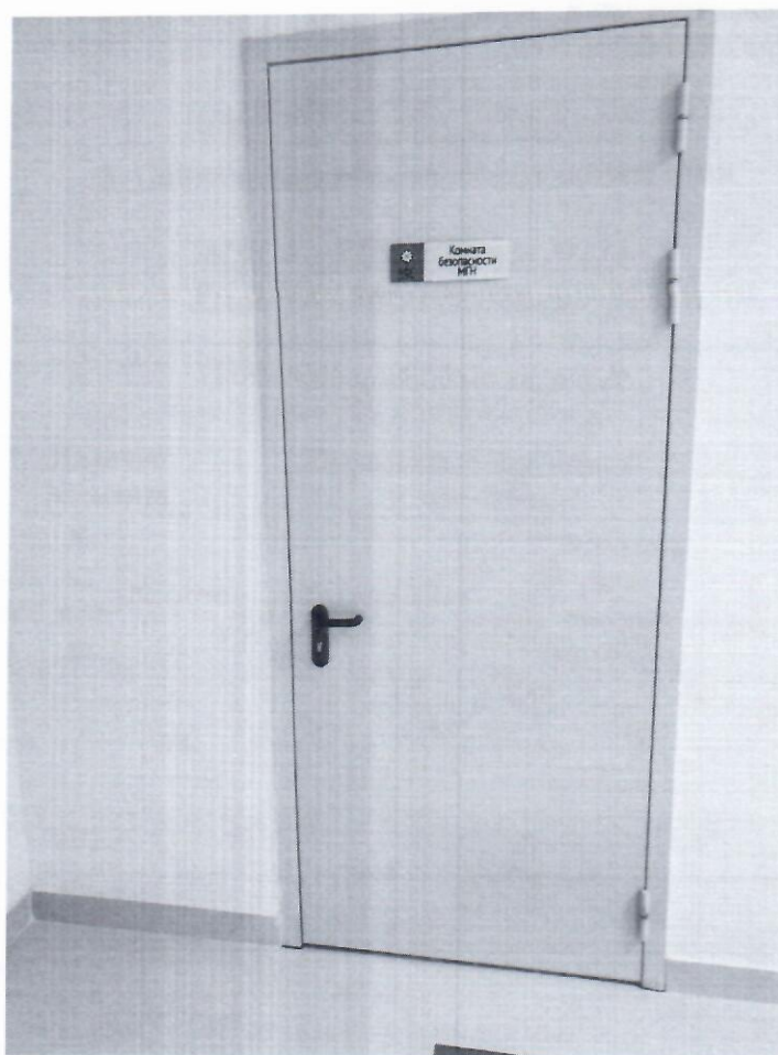
Фото 12. Комната безопасности МГН
