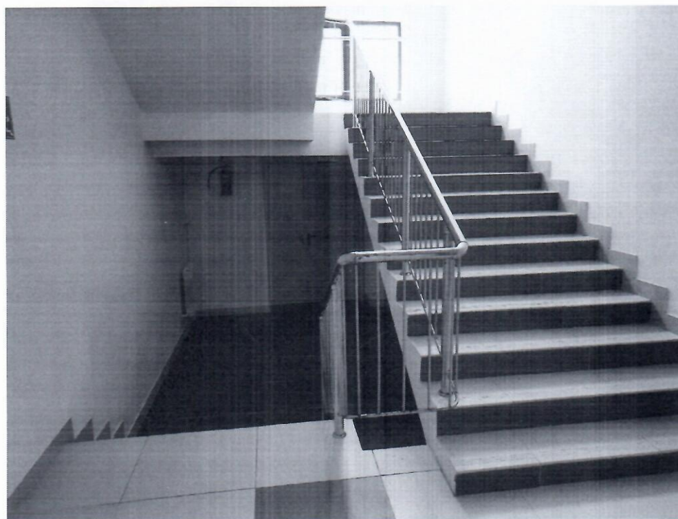
Фото 8. Лестница (внутри здания)
